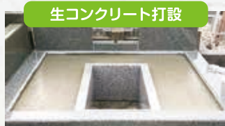
生コンクリート打設
