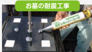
お墓の耐震工事
